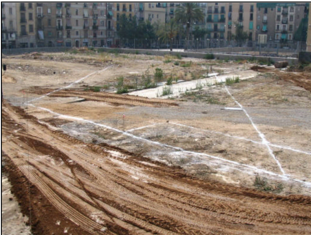
Foto núm.170 Replanteig de la rasa B800
