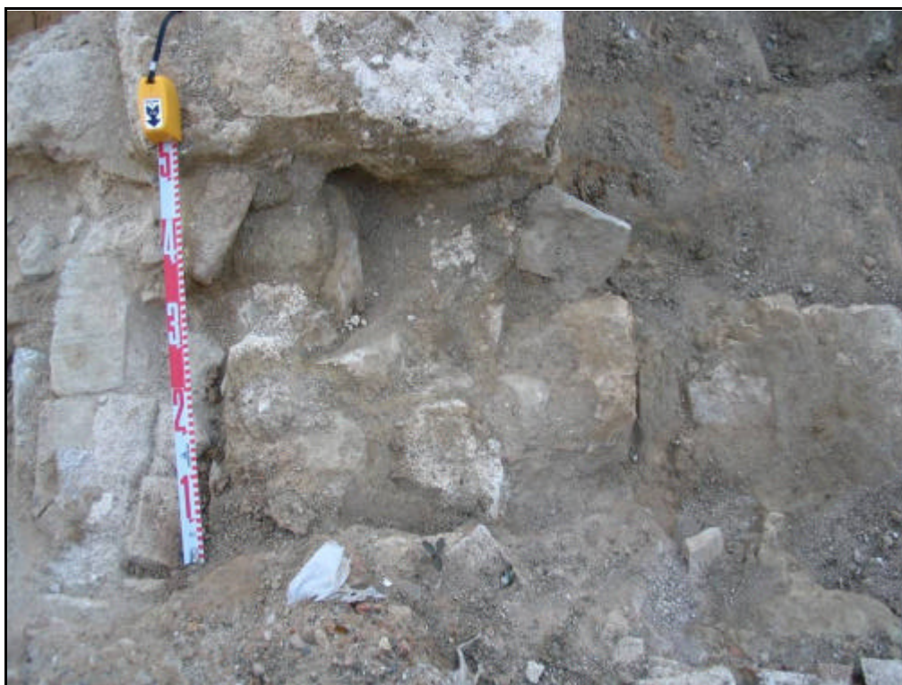
Foto núm.82 Mur UE20799
