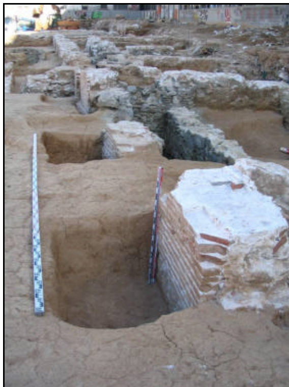
Foto núm.21 Sabates de fonamentació UE20614 i UE20616
