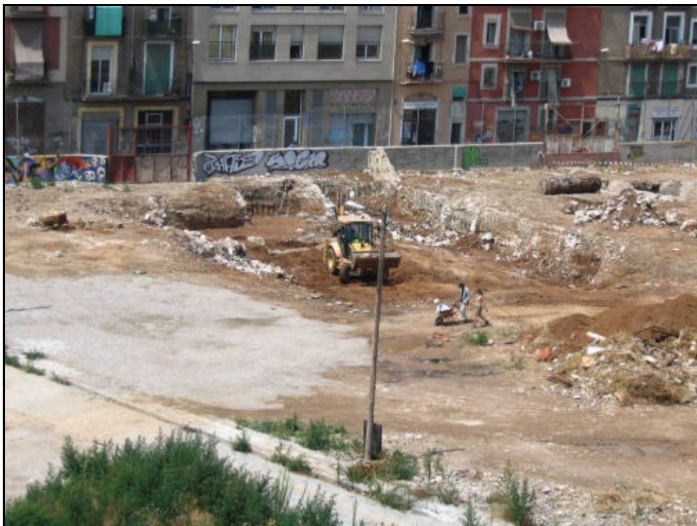
Foto núm.117 Vista general. Inici dels treballs
