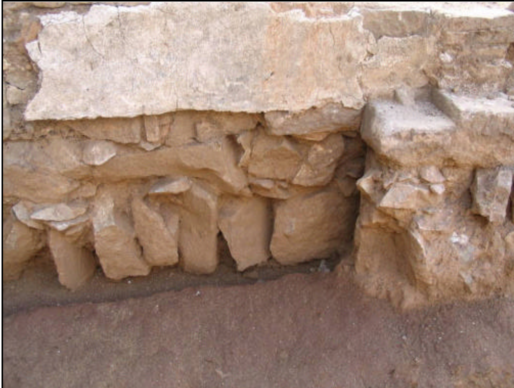
Foto núm.77 Mur UE20418
